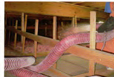
天井に断熱材を吹き込んでいる状況です
